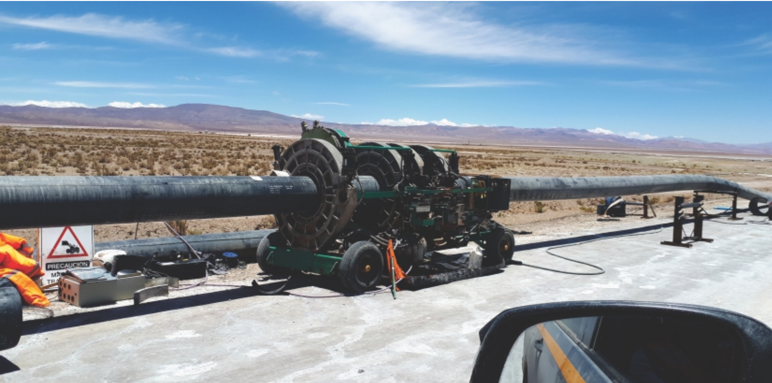
Trabajos en Piping / Ene20
