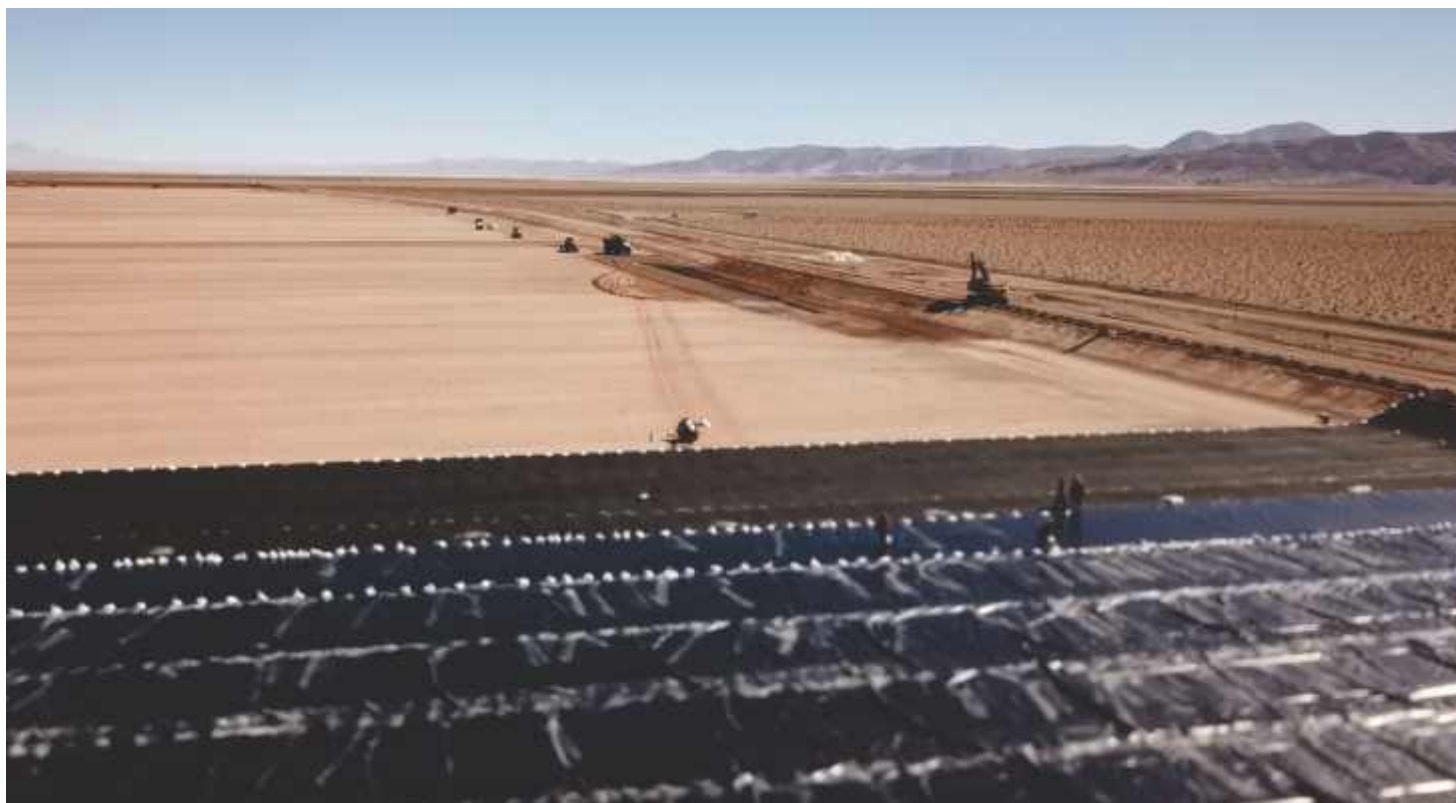
Diciembre de 2018, construcción Poza A
