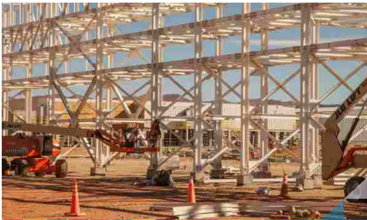
Ago 21 / Avances en construcción
