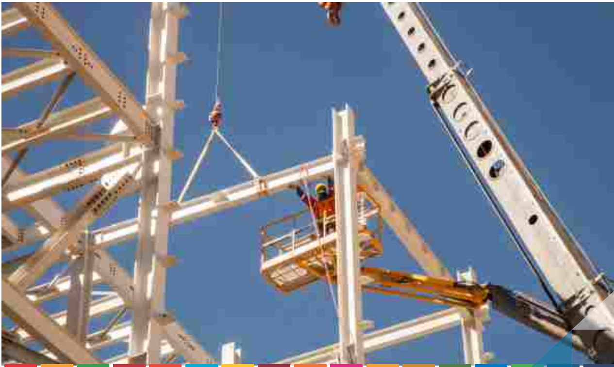
Set 21 / Avances en construcción
