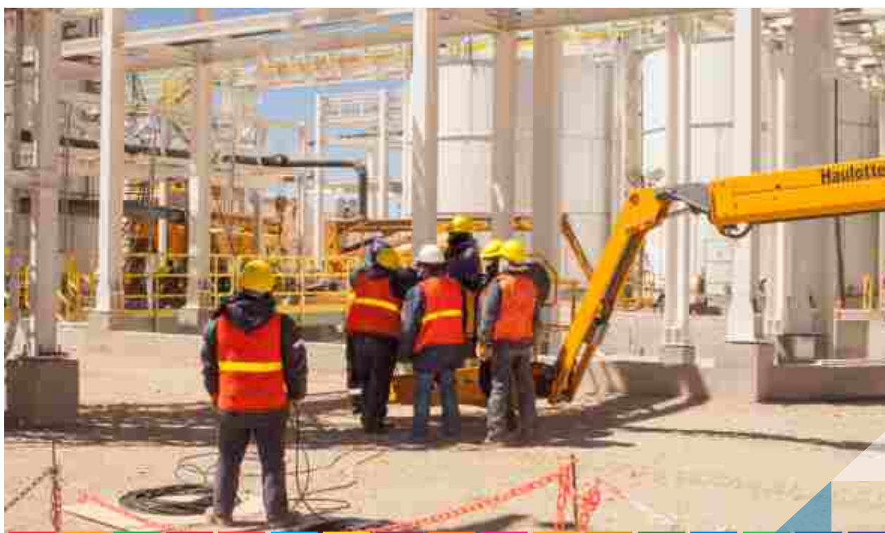
Nov 21 / Actividades en construcción
