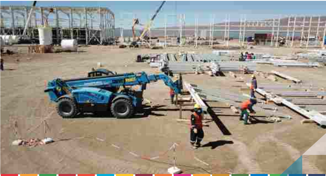
Ene 21 / Actividades de construcción
