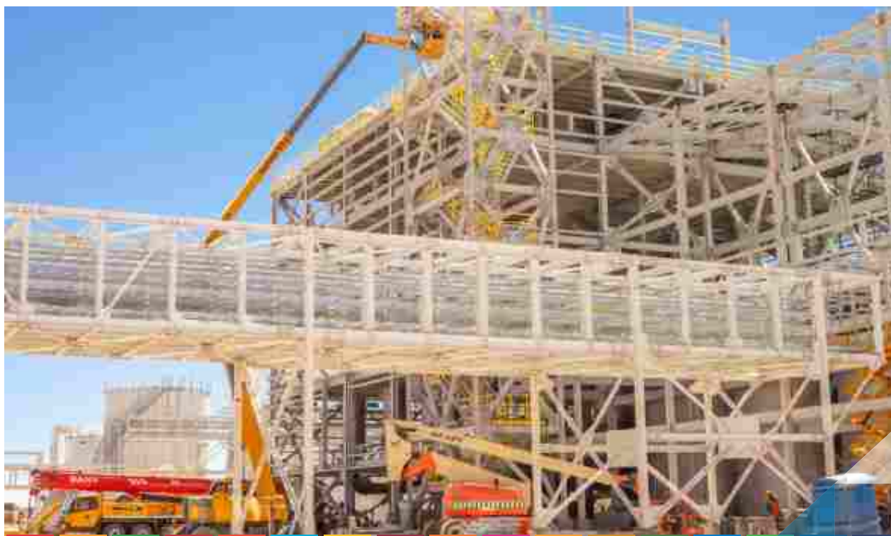
Nov 21 / Avances construcción Planta KCI
