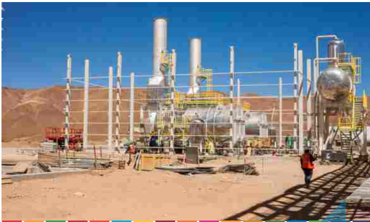
Nov 21 / Avances en construcción
