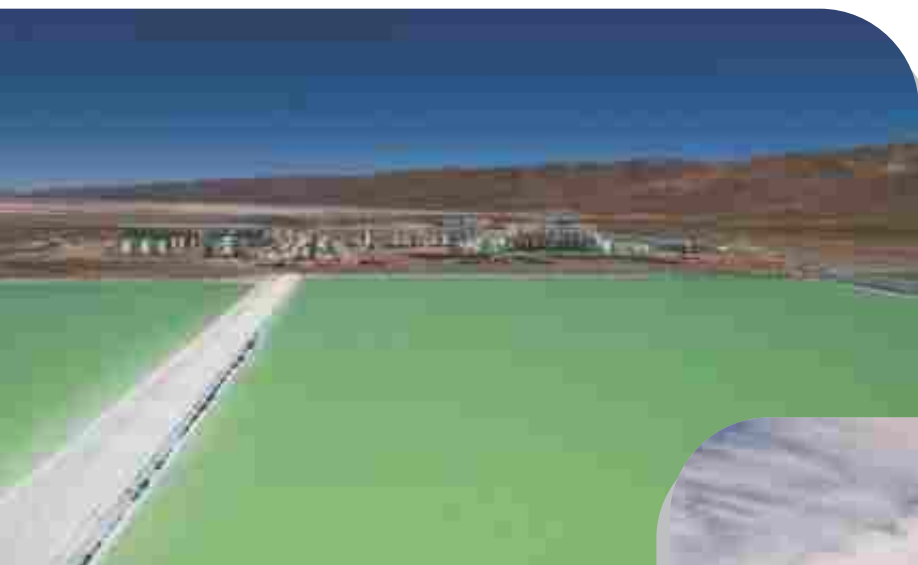
Avances Construcción Segundo Semestre 2021.
