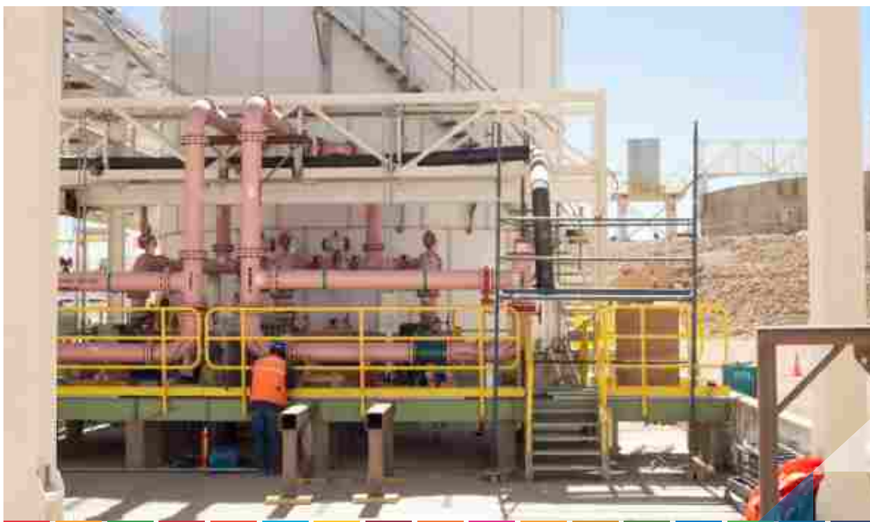
Set 21 / Trabajos en Planta de Cal
