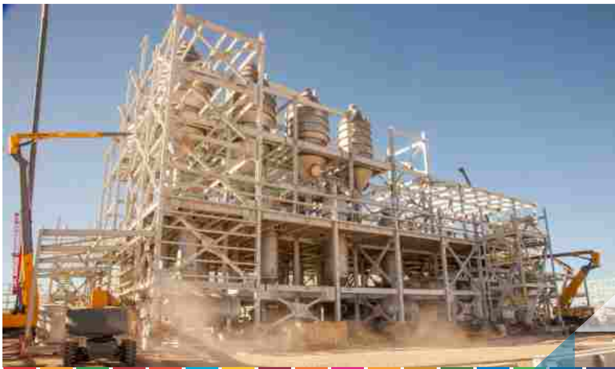
Ago 21 / Construcción Planta KCI
