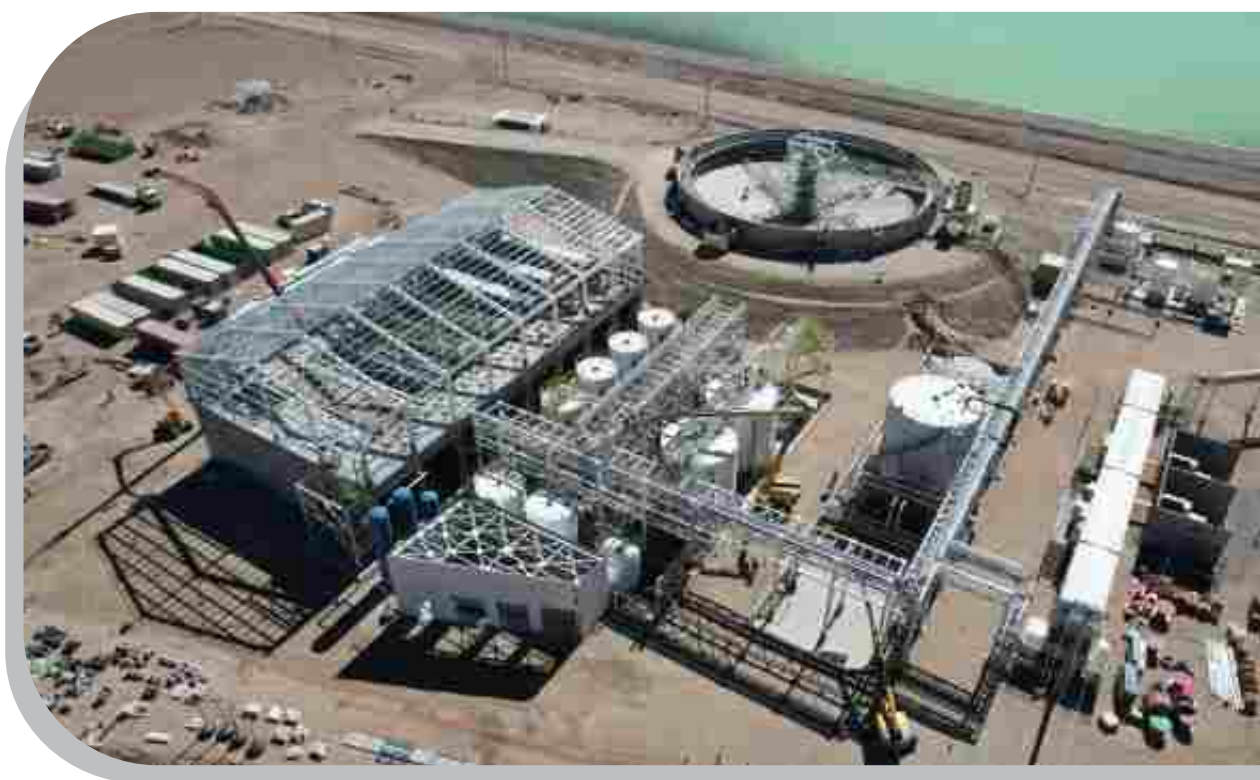
Planta de separación sólido/líquido. Obra Civil- GECO. Montaje UTE PM/BSD.
