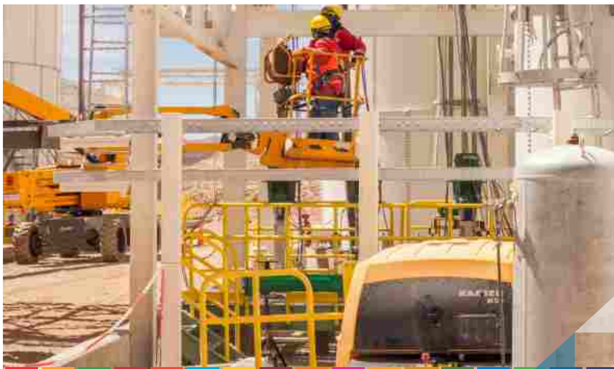
Set 21 / Avances en construcción
