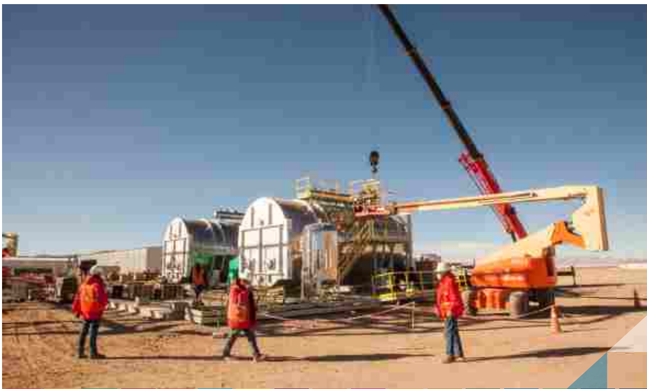
Ago 21 / Avances en construcción
