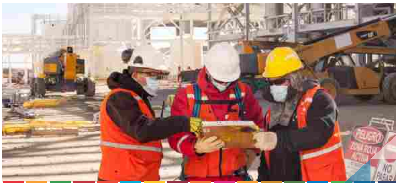
Oct 21 / Actividades de construcción
