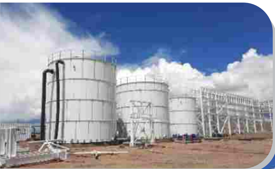
Avances Construcción Primer Semestre 2021.
