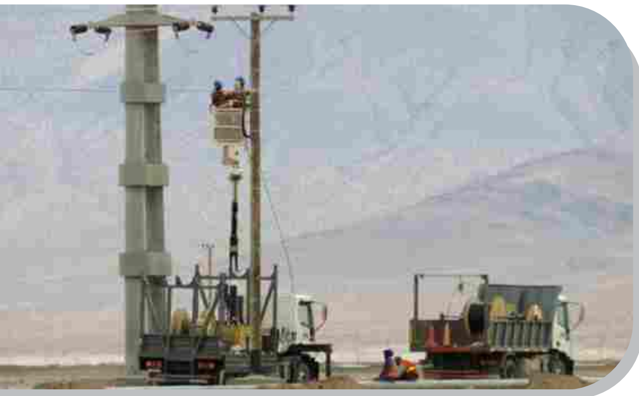
Tendido de fibra óptica, Obra Civil Empresa Magna.
