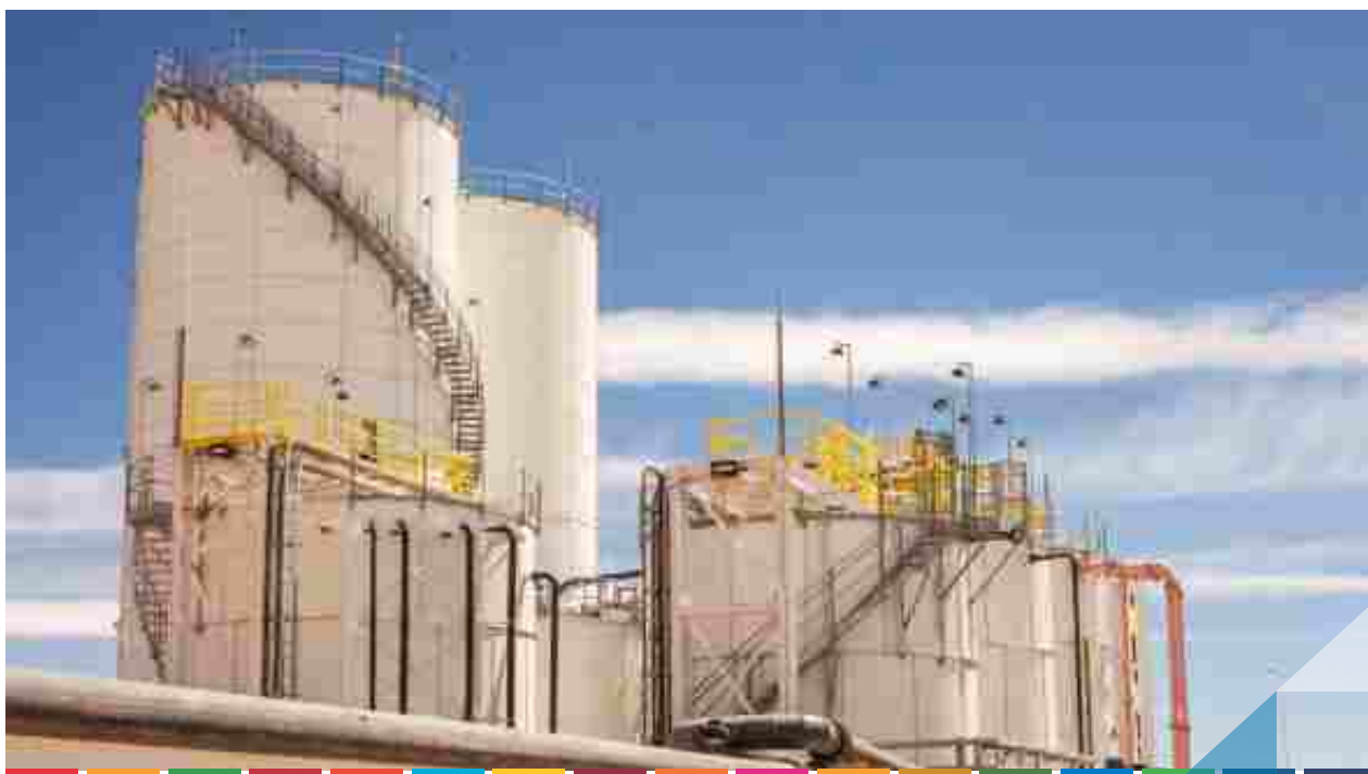
Set 21 / Trabajos en construcción planta
