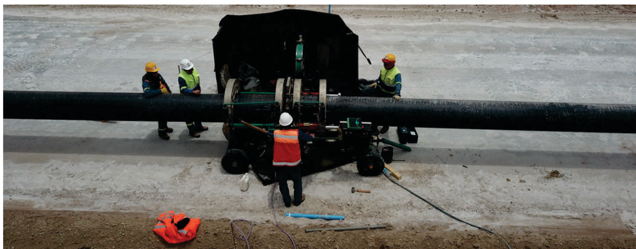
Trabajos en tuberías
