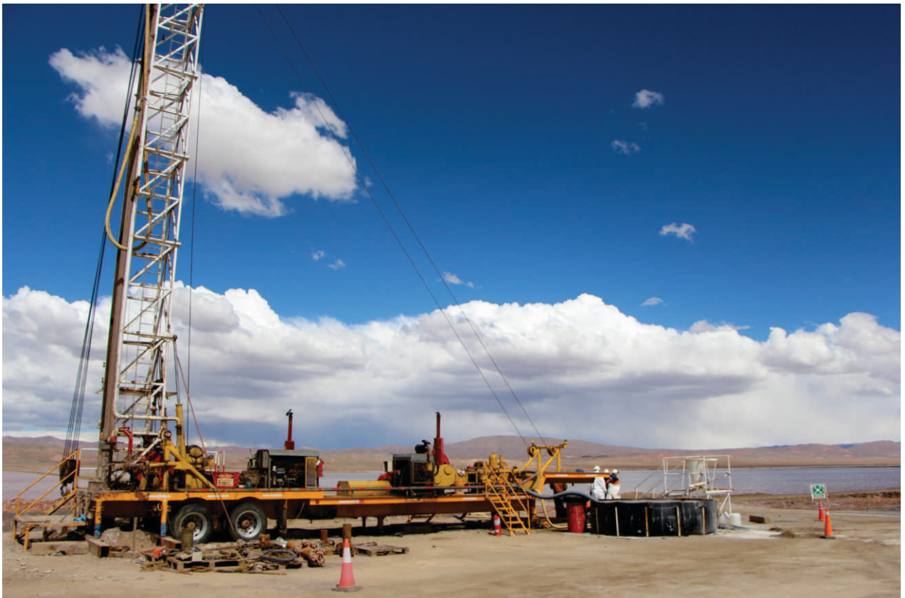
Plataforma de perforación
