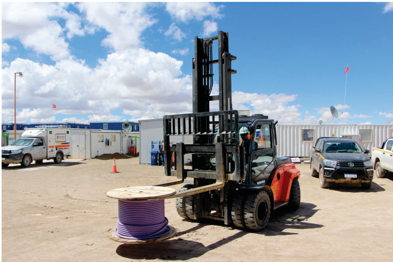
Actividades en Campamento de Construcción y Planta Piloto
