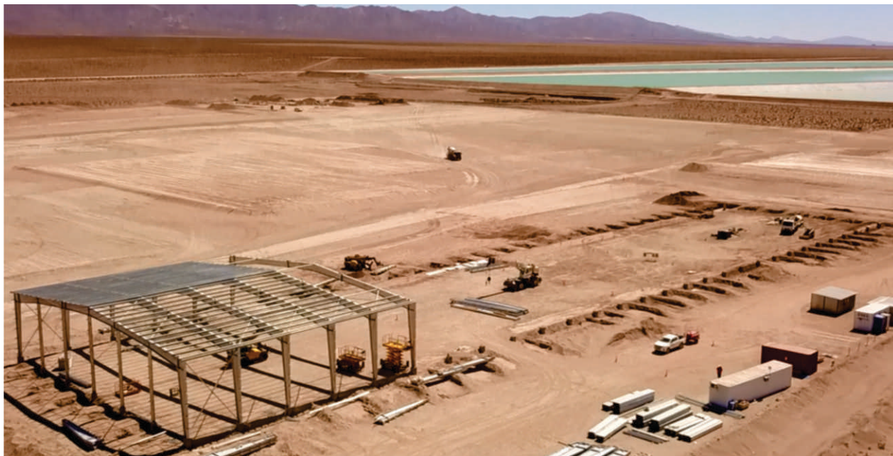
Avances de Construcción Planta
