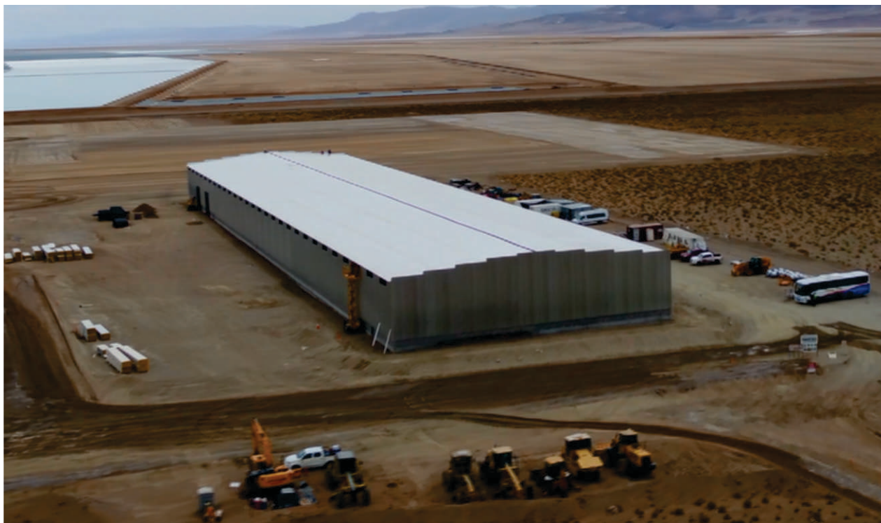
Avance de construcción de planta de carbonato de litio
