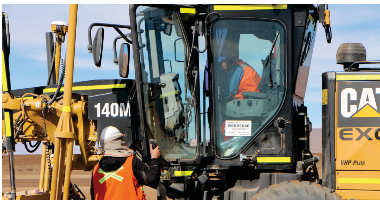
Trabajos en Pozas
