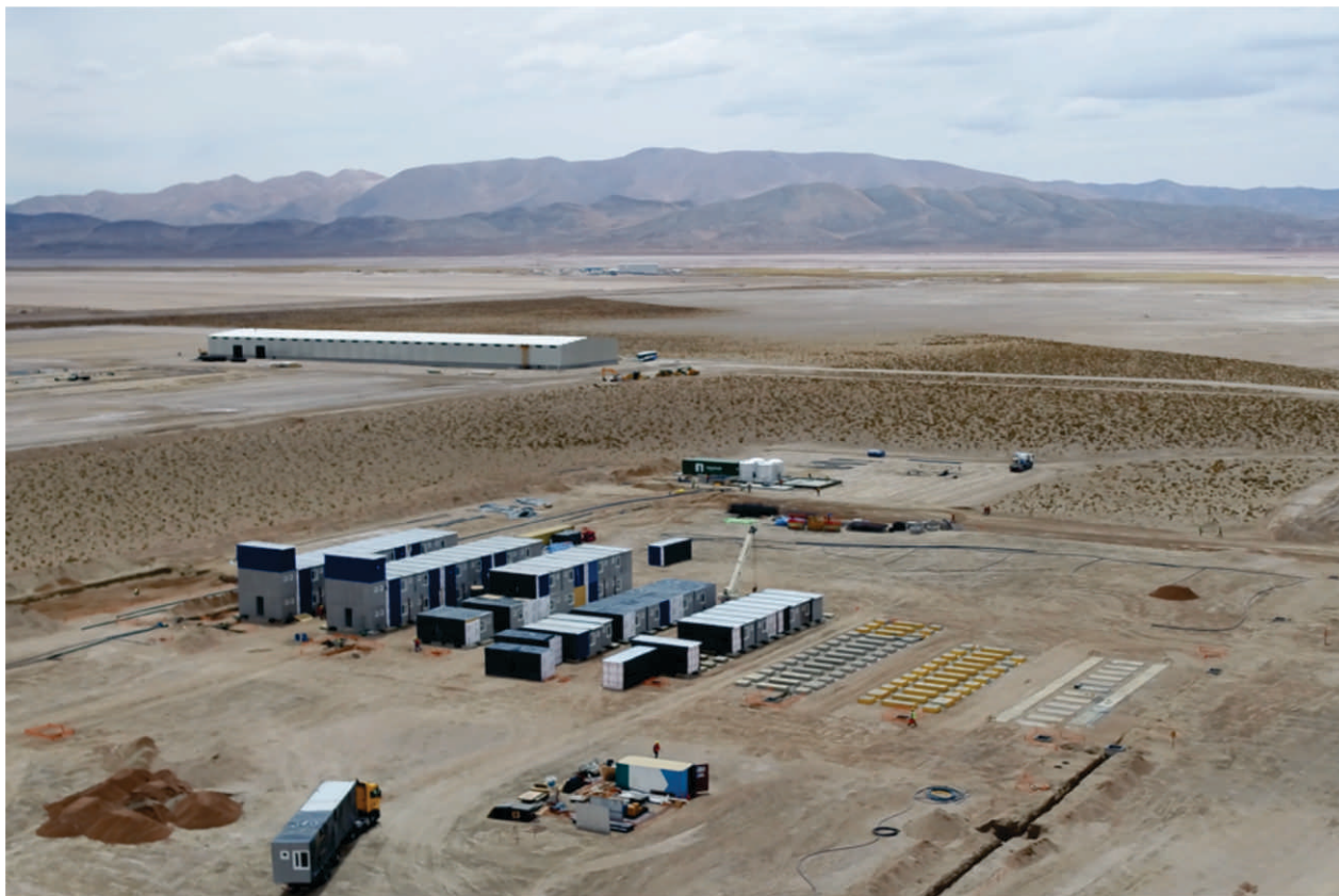
Construcción Nuevo Campamento
