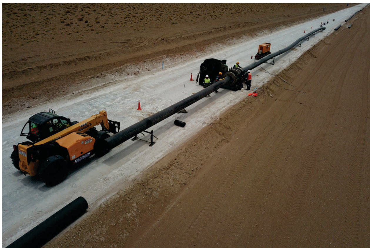
Trabajos en tuberías
