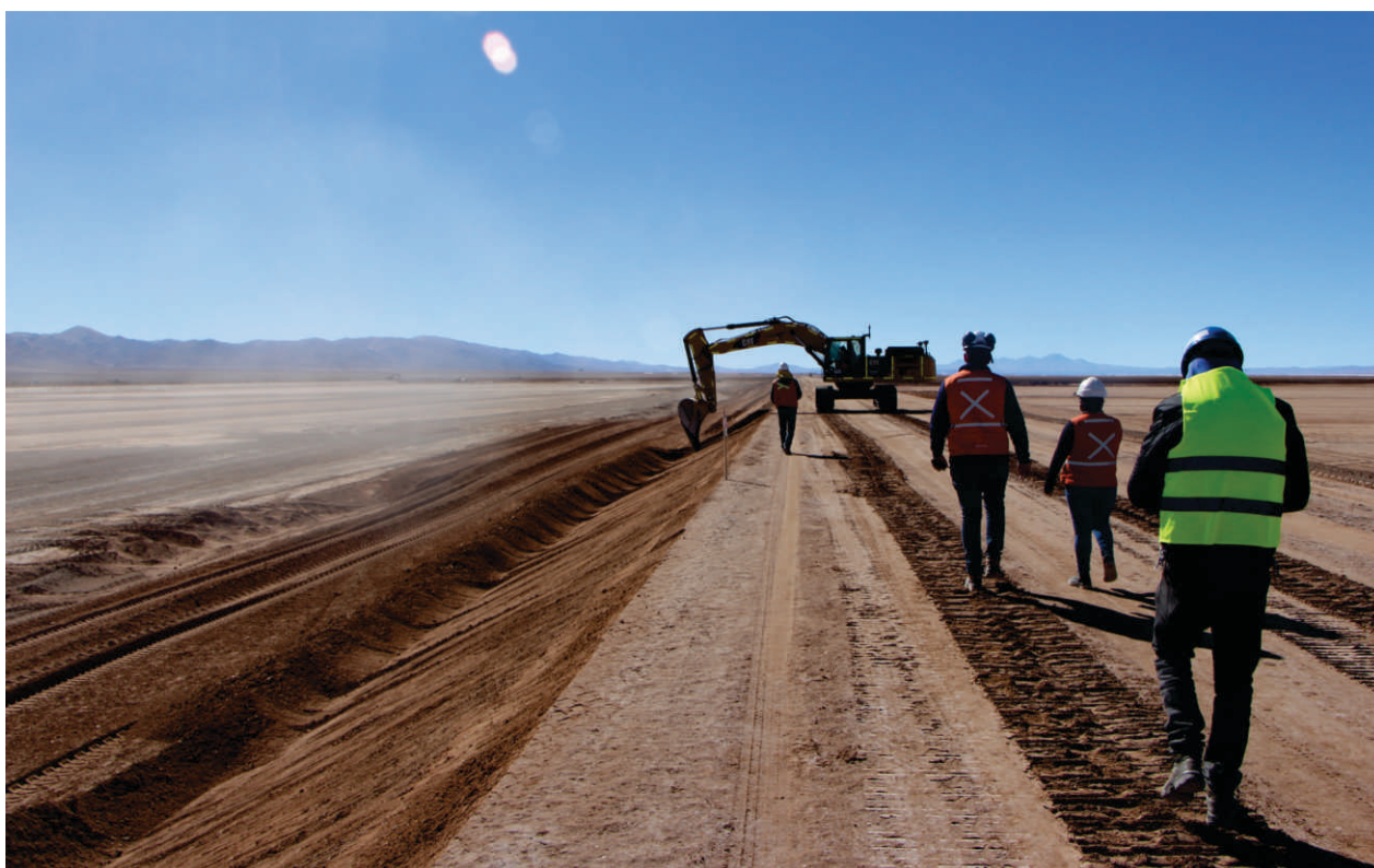
Trabajos en Pozas
