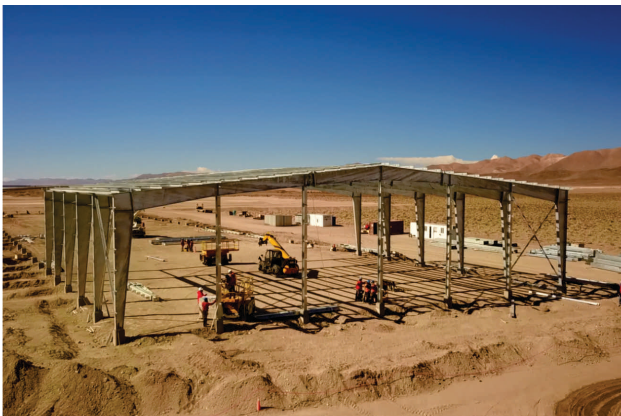
Avance de construcción de planta de carbonato de litio
