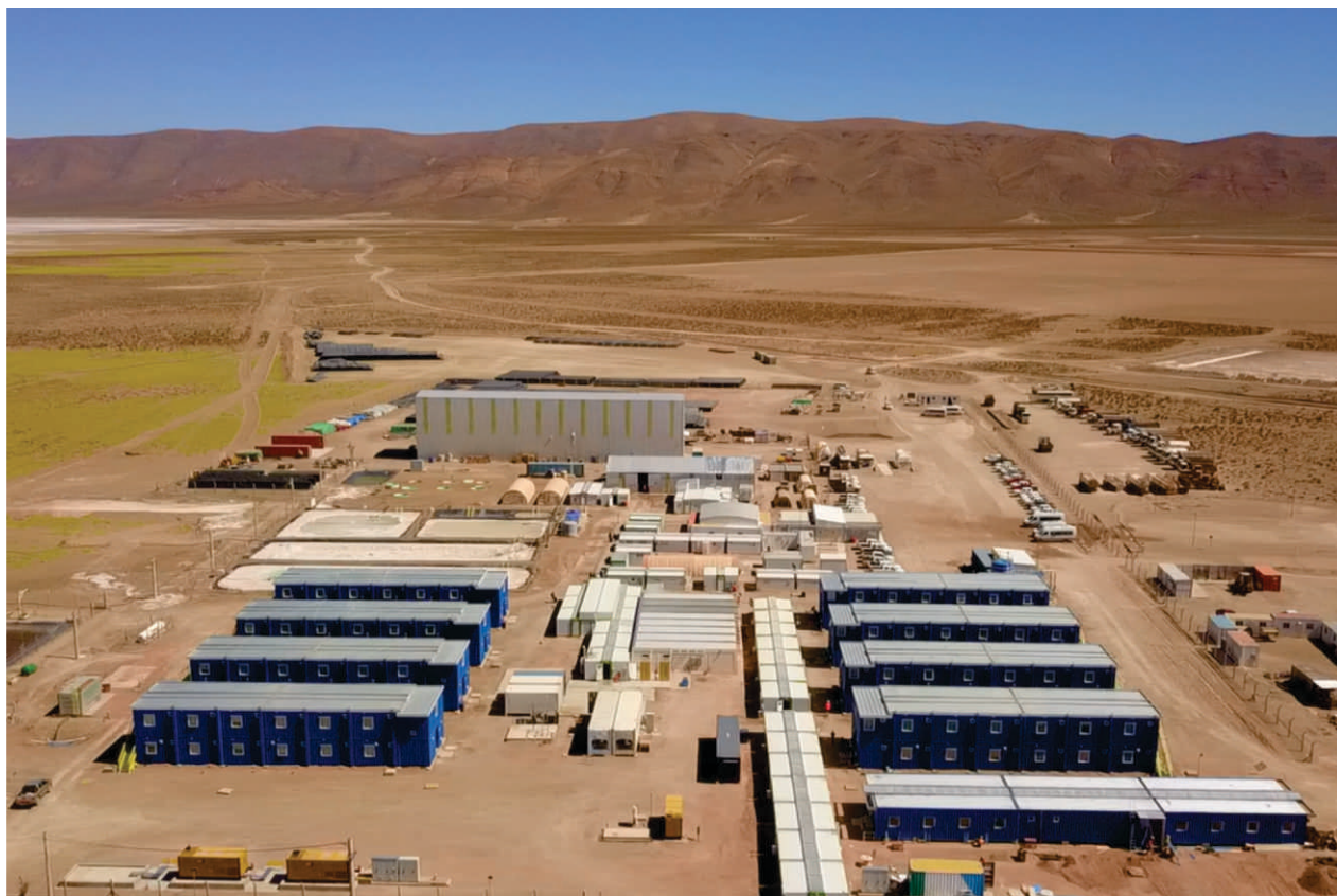
Campamento de construcción y Planta Piloto
