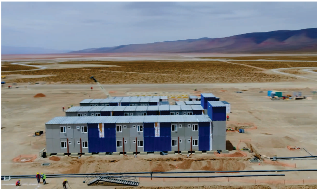
Construcción Nuevo Campamento
