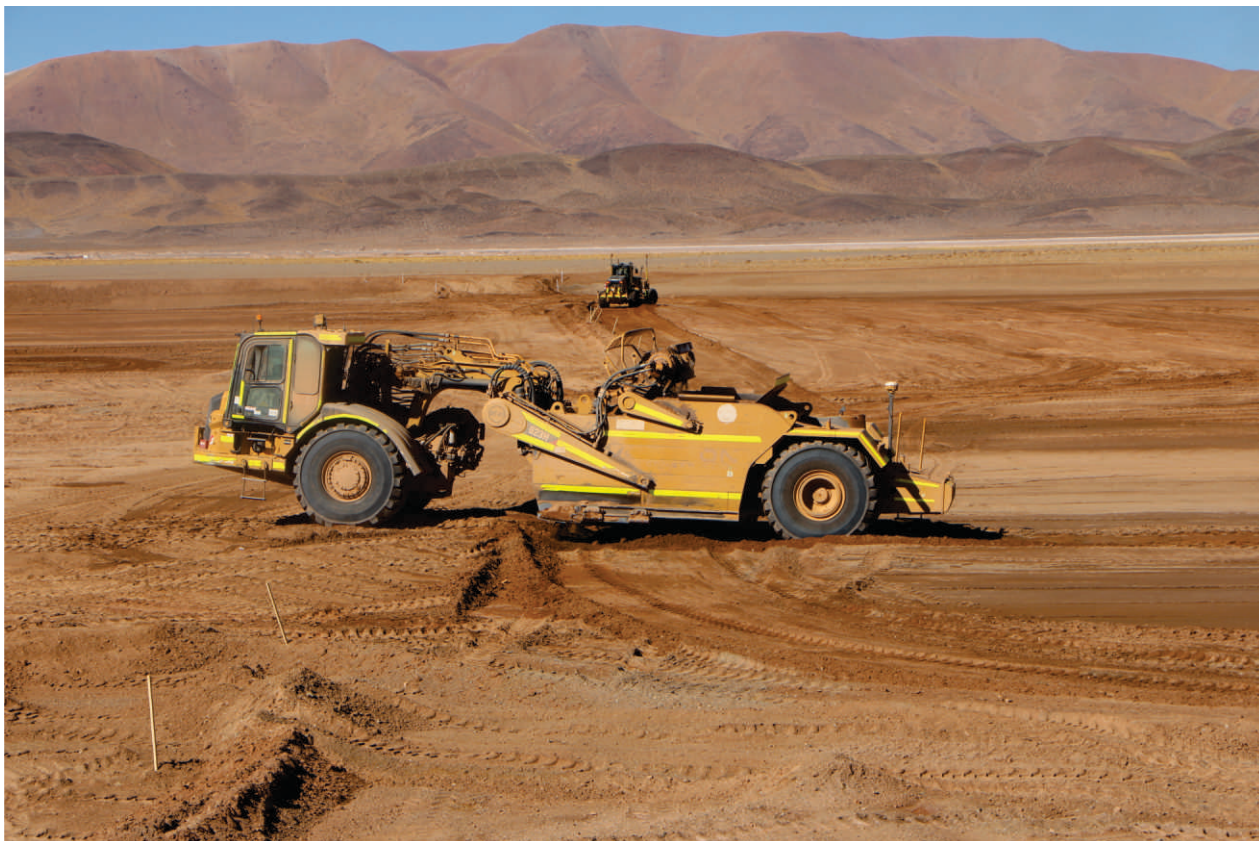
Trabajos de Movimiento de Suelos en Pozas
